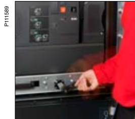
Afbryderchassis drejet i adskilt stand.
